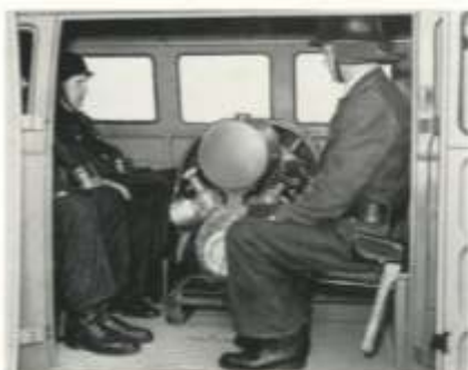
Im Mannschaftswagen finden acht Feuerwehrmänner bequem Platz. Bei Bedarf kann die mittlere Sitzbank herausgenommen und zusätzlich eine Tragkraftspritze transportiert werden. Im Heckraum des Mannschaftswagens ist reichlich Platz für Schläuche und Kibeltspritzen.
