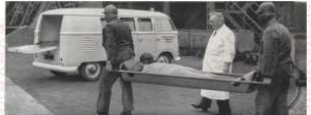
médical monté sur glissière. Il s'agit en fait d'un brancard assis, des tubes télescopiques permettent en effet d'en faire une lourde chaise à porteur. Au total, il est possible d'emporter trois blessés, deux infirmiers et un chauffeur.
